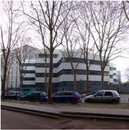
Vue du bâtiment existant
